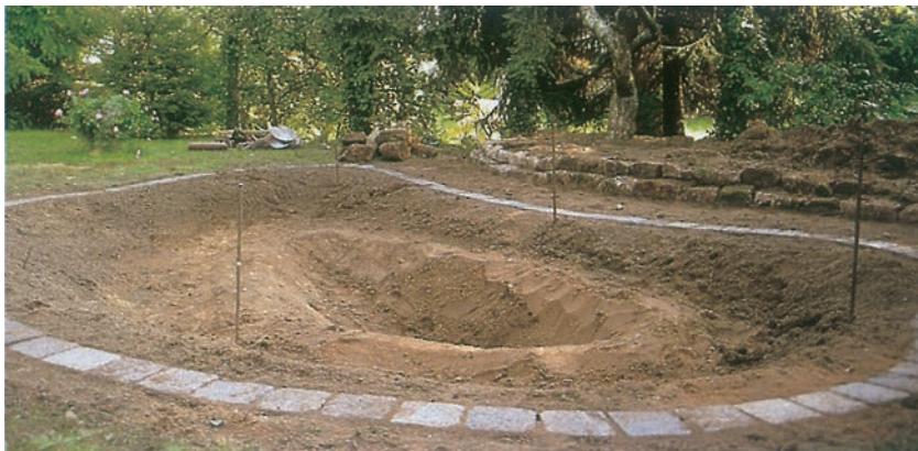
Fertig ausgehobenes Teichprofil. Der Aushub wird in unmittelbarer Nähe gelagert.
